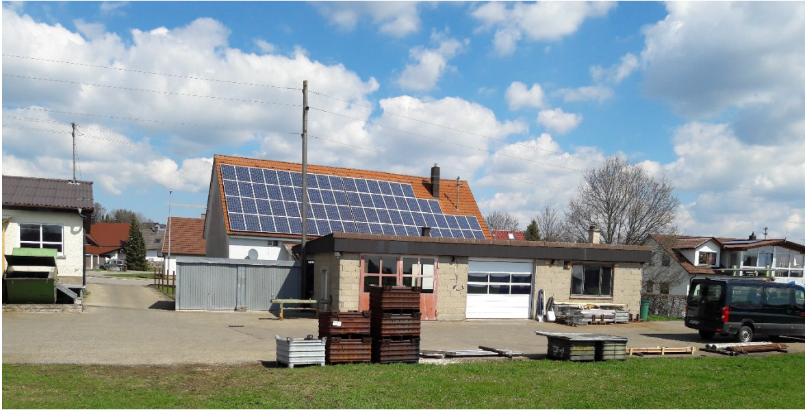
Abbildung 2: Sägehalle, Ansicht von Süden
