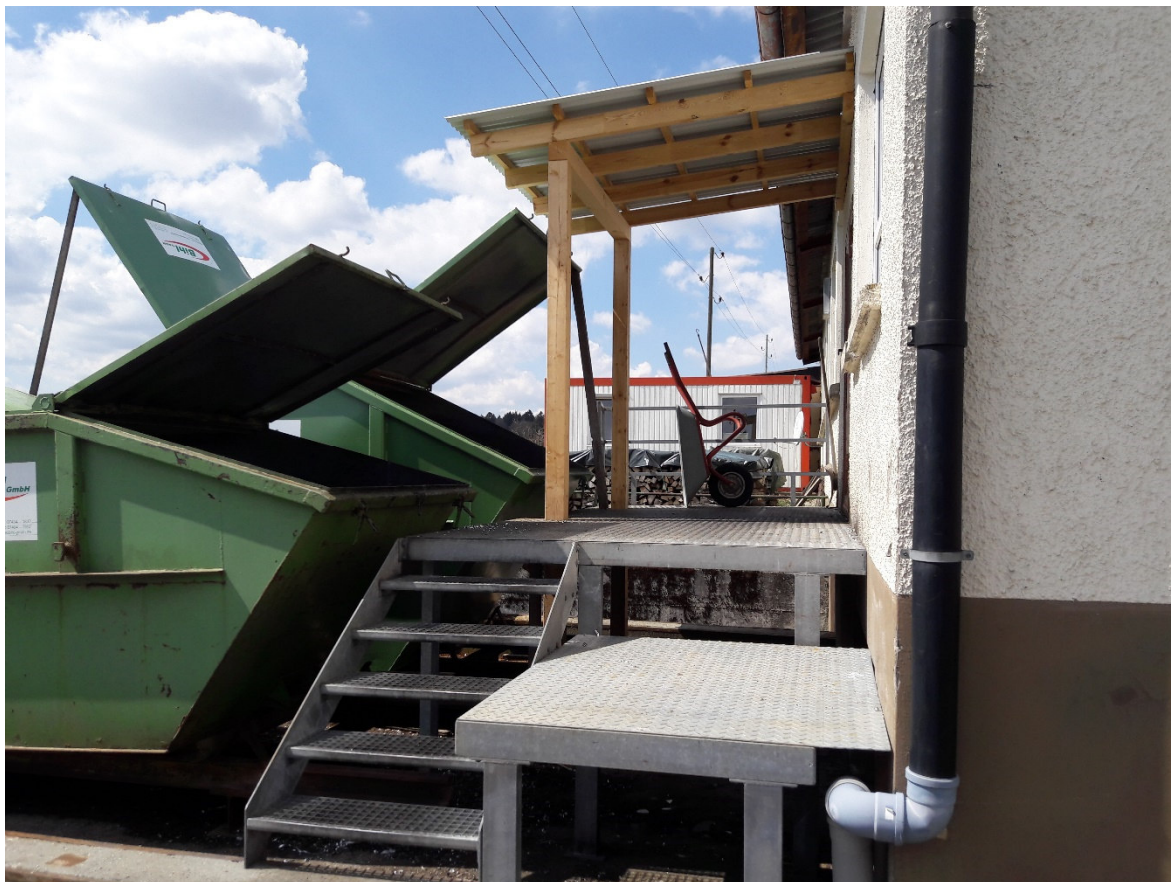
Abbildung 3: Seitliche Ansicht der Südfassade (Maschinenhalle) mit Containern.
