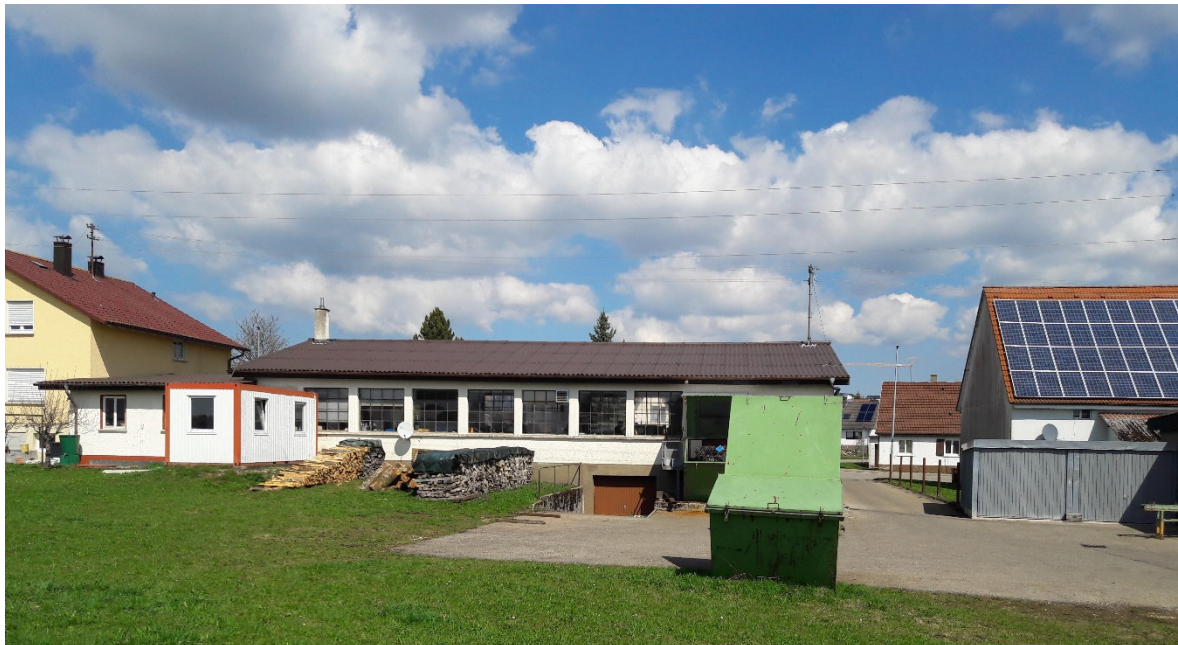
Abbildung 1: Maschinenhalle, Ansicht von Süden
